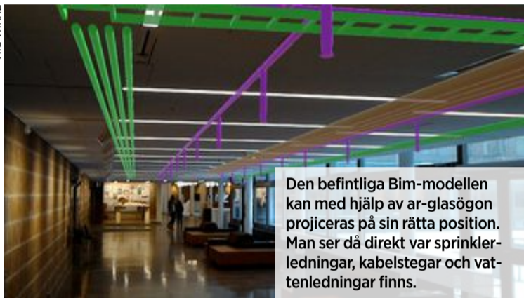
Den digitala informationen om var vattenledningar, ventilationsrör och så vidare kan projiceras i det verkliga rummet med hjälp av ar-glasögon.
